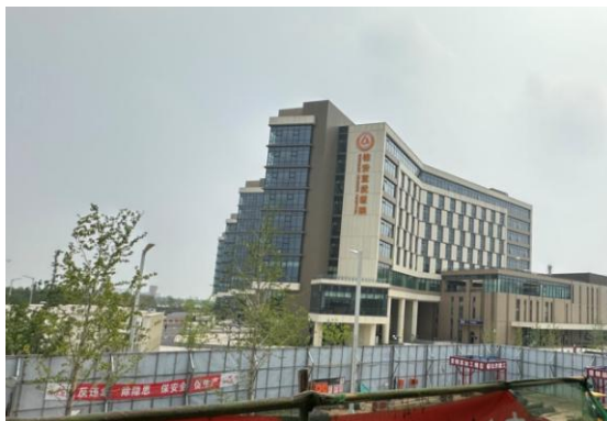
a. 东侧住院 1 号楼
